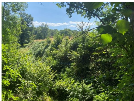
La digue avant et pendant débroussaillage
